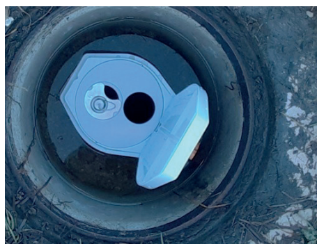
Piézomètre dans un regard, utilisation d'un anneau intermédiaire
